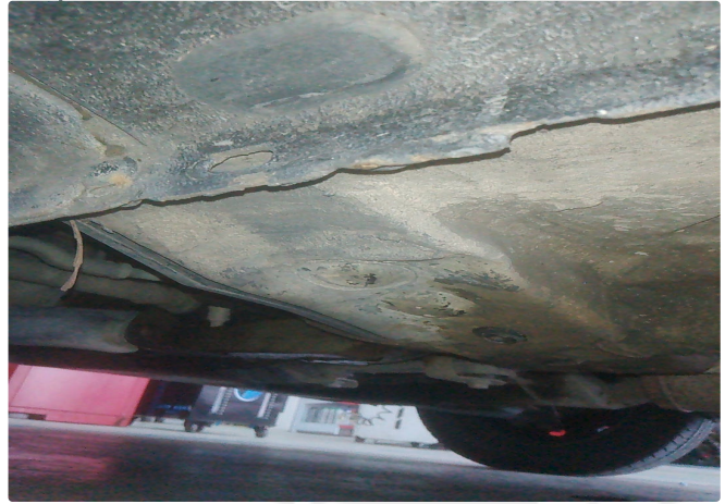
Travessa do assoalho do mono bloco amassado do lado esquerdo
