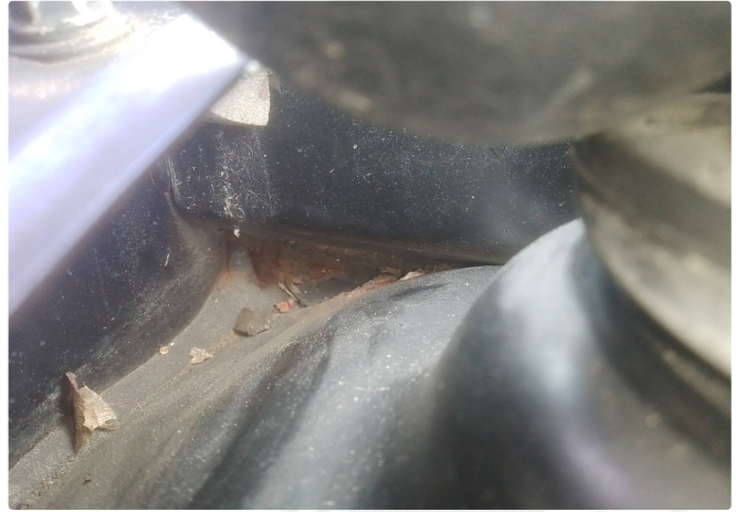
Corrosão acentuada na torre do amortecedor dianteira direita
