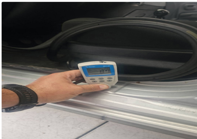
Caixa de ar/soleira esquerda
