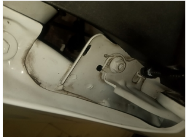
Foto Extra 14 SEM REPAROS/AVARIAS
